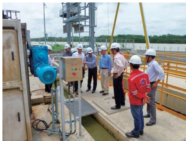
現場ケーススタディ (Nhon Trach Power Plant)
