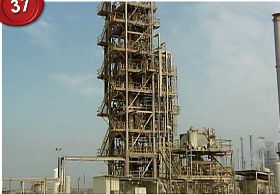
2003年 サウジアラビアと共同で実施したプロジェクト高過酷度流動接触分解 (HSFCC) サウジアラムコ・ラスタヌラ製油所内に30BDの実証化装置を設置、運転を開始
