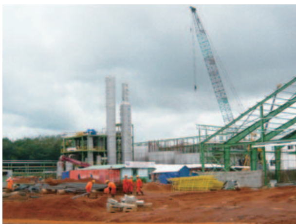
バイオエタノール工場建設現場
