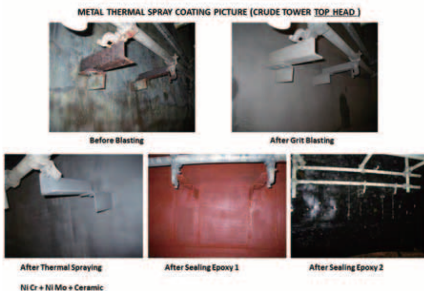
図 3 腐食対策例
