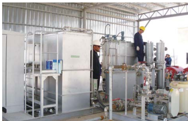
日本からノース・ルメイラ油田の施設に移設されたパイロット・プラント
