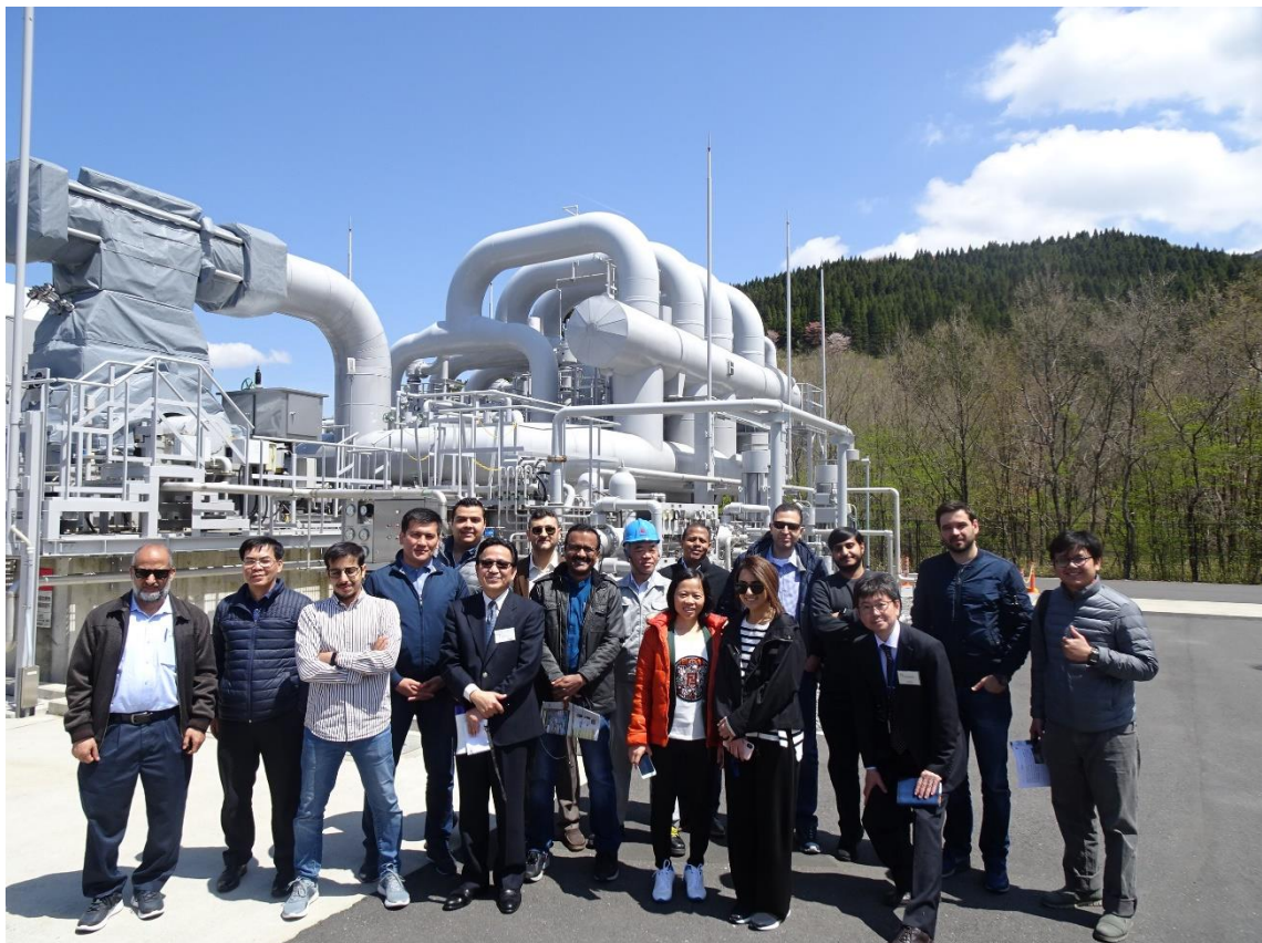
出光大分地熱（株） 滝上バイナリー発電所
