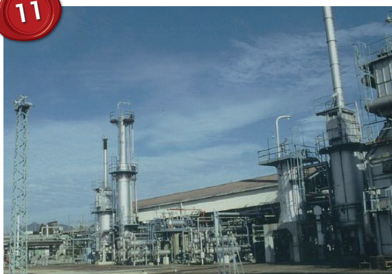
1985年2月 徳山訓練プラント（出光興産㈱徳山製油所内）完成
