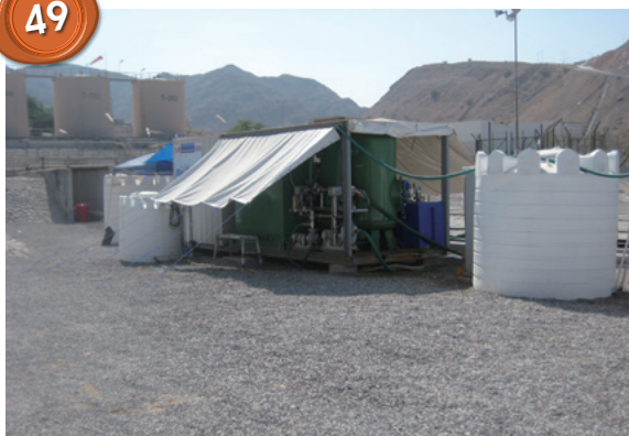
2007～2010年度 オマーンにおける油田随伴水の処理とその利用に関する調査を行った。稼働式パイロットプラントの全景
