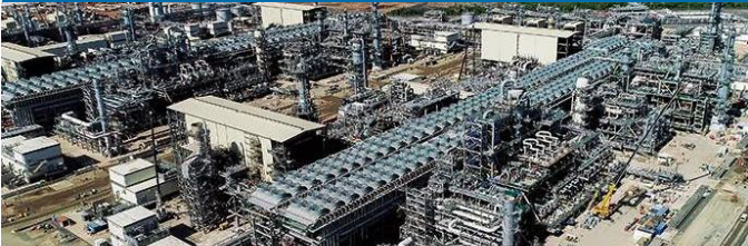
LNG Plant for Ichthys LNG, Australia
