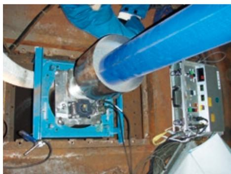
触媒デンス充填作業(反応塔内)
