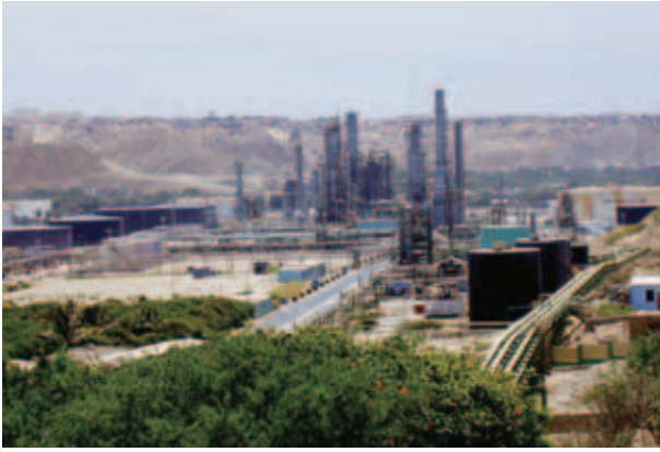
ペトロペルー タララ製油所
