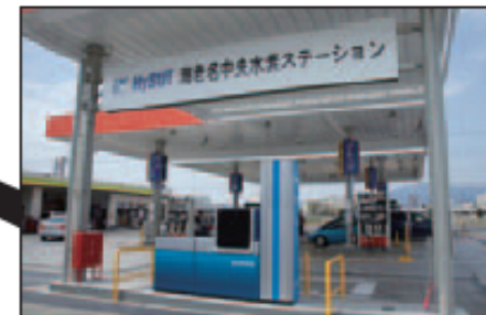
水素充填機 Hydrogen dispenser
